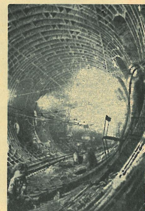
Uzávřený hlubinný způsob ražení tunelu. Zelezobetonové a ocelové výztuže hermeticky chrání prostor tunelu před prosakováním podzemních vod.
